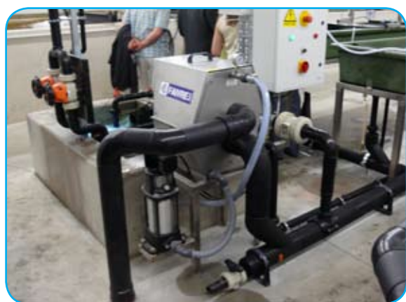
Filtre série 1-40 sur cuve (dans une ferme d'esturgeons)
